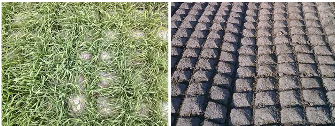
نگاره ۳۶: استفاده از شبکه زیرین و اجرای خشکه‌چین Rip-rap در همخوانی با طبیعت
