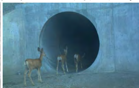
نگاره ۱۵۴: راست: عبور آهوی وحشی از آبرو با ابعاد مناسب، ایالت کلرادو، چپ: زیرگذر عبور دوزیستان، سویس
