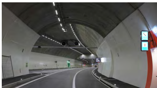
نگاره ۱۳۶: عدم نورپردازی داخل تونل و هدایت دید راننده با رنگ سفید بدنه، تونل آیهولز گذرگاه A ۹ سوئیس
