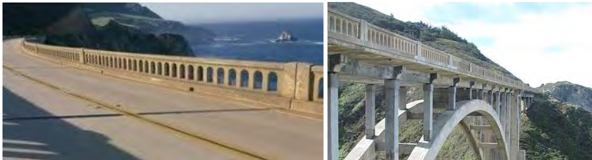
نگاره ۶۵: حفظ دید به منظر با طرح متخلخل حفاظ بتنی، پل بیکسپی، کالیفرنیا
