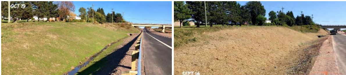
نگاره ۱۷۲: تثبیت ترانشه و راه آب ۲ زهکش طولی به روش بذرپاشی دوغابی
