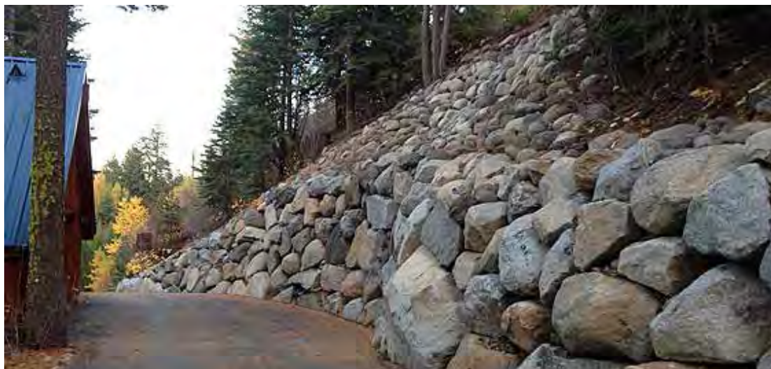
نگاره ۳۵: Rip-rap خشکه‌چین با تخته سنگ، جاده دریاچه لیک تاهو، بر کلی
