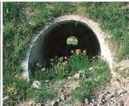
نگاره ۱۵۷: راست: پرشدن زیرگذر از ریزش خاک، چپ: کنترل شستگی خاک زیرگذر با چینش کیسه‌های خاک سرعتگیر سیلاب
