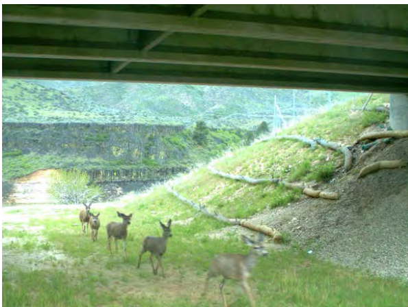
نگاره ۱۵۷: راست: پرشدن زیرگذر از ریزش خاک، چپ: کنترل شستگی خاک زیرگذر با چینش کیسه‌های خاک سرعتگیر سیلاب
