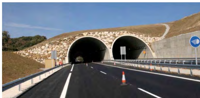
نگاره ۱۰۰: ترمیم حول تونل با مصالح همگون با بستر طبیعی
