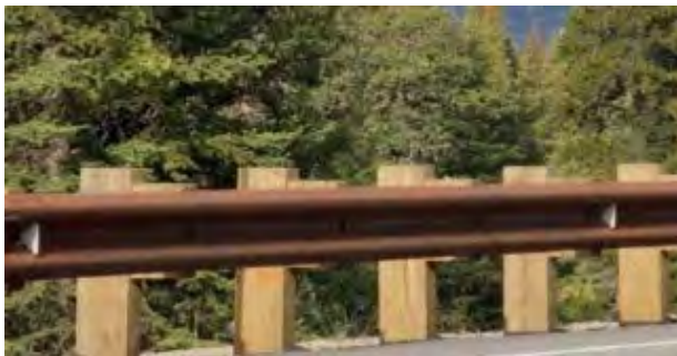
نگاره ۶۷: استفاده از ستون سنگی و چوبی برای گاردریل
