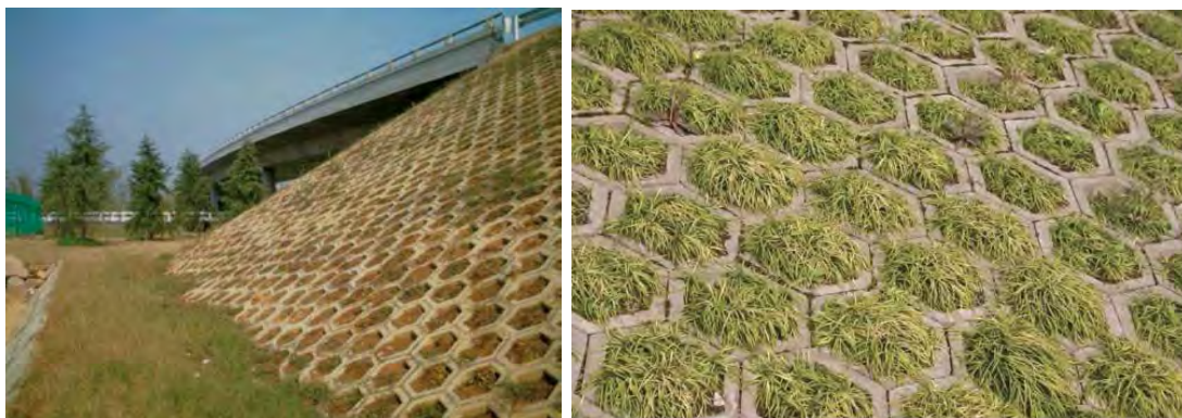
نگاره ۳۹: تثبیت خاکریز پل با کاشت چمن در بلوک بتنی توخالی پیش‌ساخته، چین
