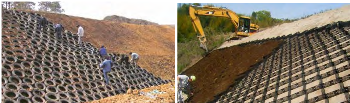
نگاره ۱۷۱: تثبیت ترانشه با اجرای ژئوسل یا تایرهای مستعمل - چین
