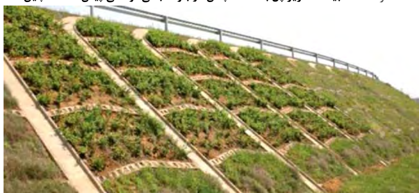
نگاره ۴۰: حفاظت از شیب تند زیر پل با ترکیب کاشت و شبکه‌بندی، پل شانگ شینگ چین
