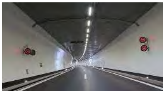
نگاره ۱۳۶: عدم نورپردازی داخل تونل و هدایت دید راننده با رنگ سفید بدنه، تونل آیهولز گذرگاه A ۹ سوئیس
