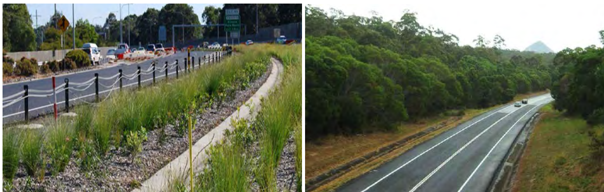
نگاره ۸۱: نمونه اجرای نهر آب در امتداد دوطرف جاده جنگلی و شهری، کوئینزلند استرالیا
