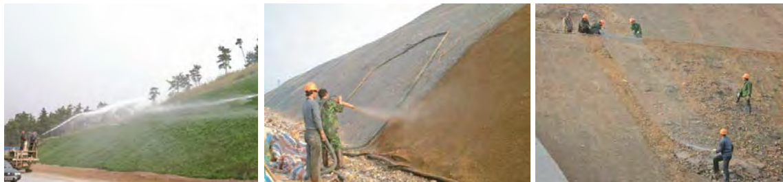
نگاره ۴۱: تثبیت ترانشه با گستردن شبکه mesh، پخش ماسه و بذر و رویش پوشش گیاهی، چین
