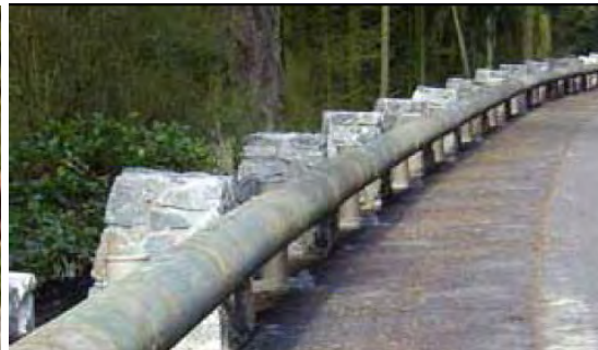
نگاره ۶۷: استفاده از ستون سنگی و چوبی برای گاردریل
