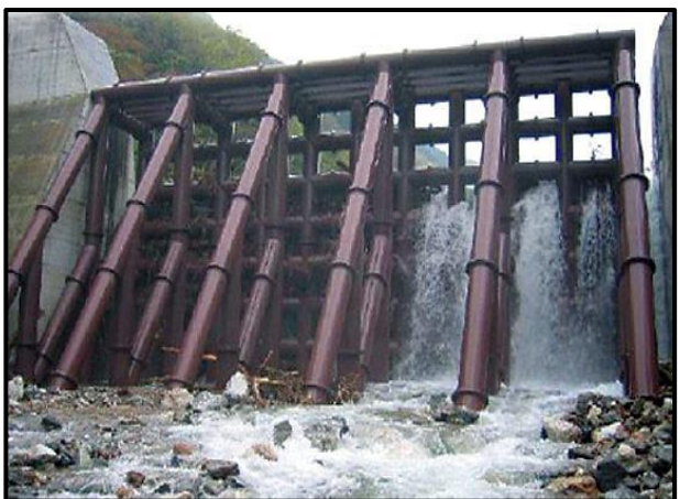
ب - نمونه‌هایی از سدهای رسوبگیر مشبک برای مهار رسوبات واریزه‌ای و قطعات سنگ و لاشه سنگ و الوار و اشجار در سطح حوضه آبریز
