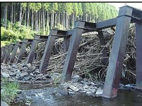
ب - نمونه‌هایی از سدهای رسوبگیر مشبک برای مهار رسوبات واریزه‌ای و قطعات سنگ و لاشه سنگ و الوار و اشجار در سطح حوضه آبریز
