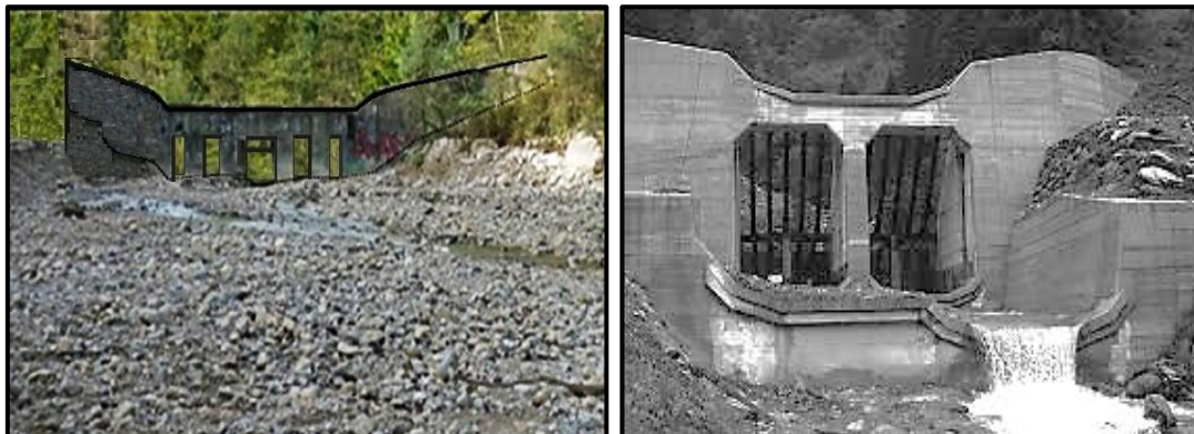
الف- نمونه‌هایی از سدهای رسوبگیر روزنه‌دار (ساده و مجهز به شبکه فلزی برای تله‌اندازی اجسام شناور)- Slot dams
