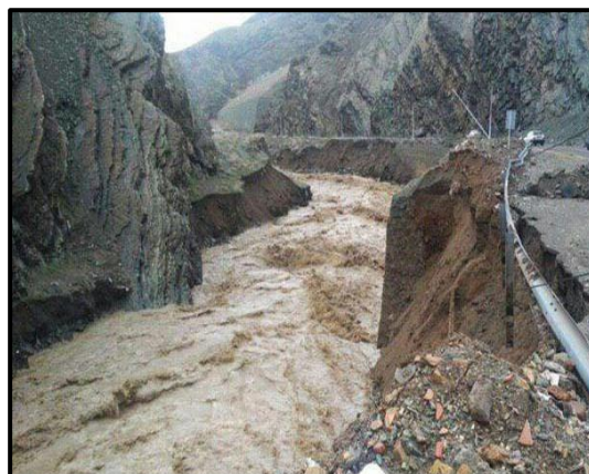
نمونه‌ای از قدرت تخریبی سیلاب در بازه‌های کوهستانی - فرسایش حاد کناره‌ها و انتقال مواد واریزه‌ای و مصالح درشت - سیلاب فروردین ماه ۹۸ - جاده سولقان
