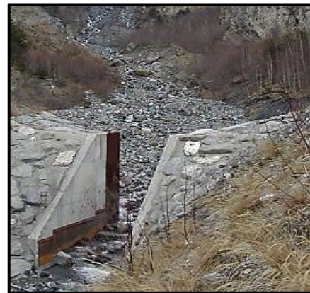
الف- سد رسوبگیر با شکاف منفرد برای تله‌اندازی بار بستر ب- سد رسوبگیر با شکاف منفرد با هدف مهار لاشه سنگ و صخره سنگ
